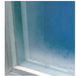
Mit konventionellen Metall-Abstandhaltern ist Kondensation oft gegeben.
